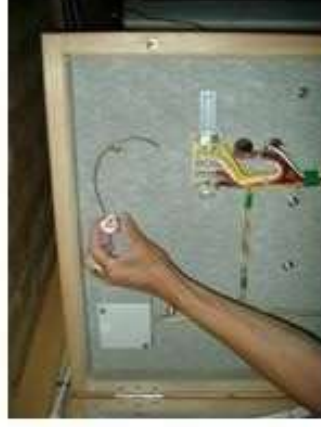
3. Löschpille montieren
